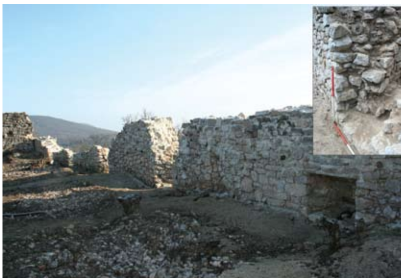
5. kép Szádvár. A külső vár déli fala a konzerválást követően. A kis képen a 3. lőrés a faragott kő és a keresztgerenda kitisztított fészkeivel
