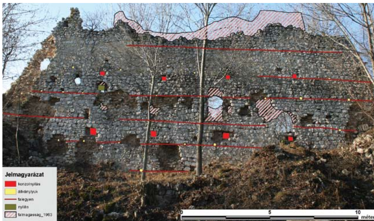
6. kép Szádvár. A Porkoláb-falról készített georeferált fotó az építészeti részletek jelölésével
