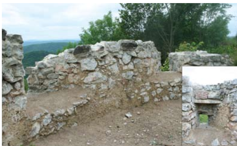
2. kép Szádvár. A Lisztes-bástyán végzett konzerválás eredménye. A kis képen a részlegesen helyreállított 3. lőrés
